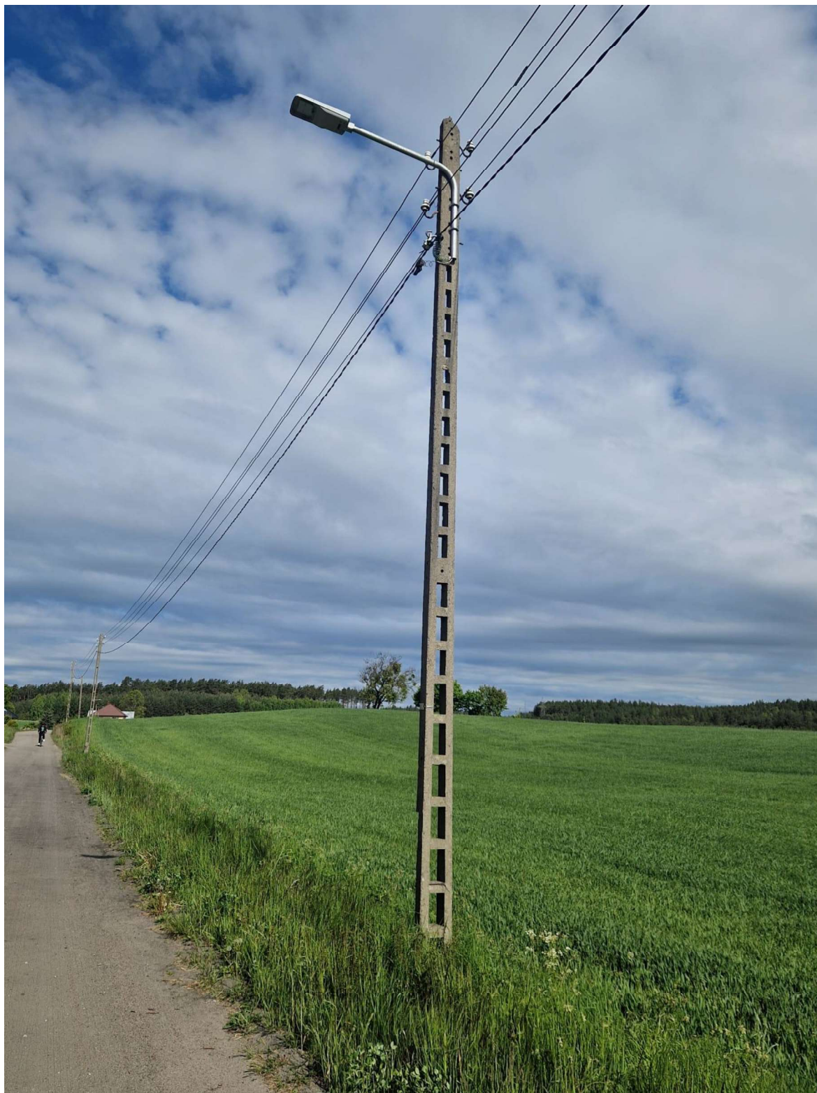
Istn. słup linii napowietrznej nN nr: 209/P (9DANA) do wymiany na słup nr: 209/P (10,5/4,3(E)).
