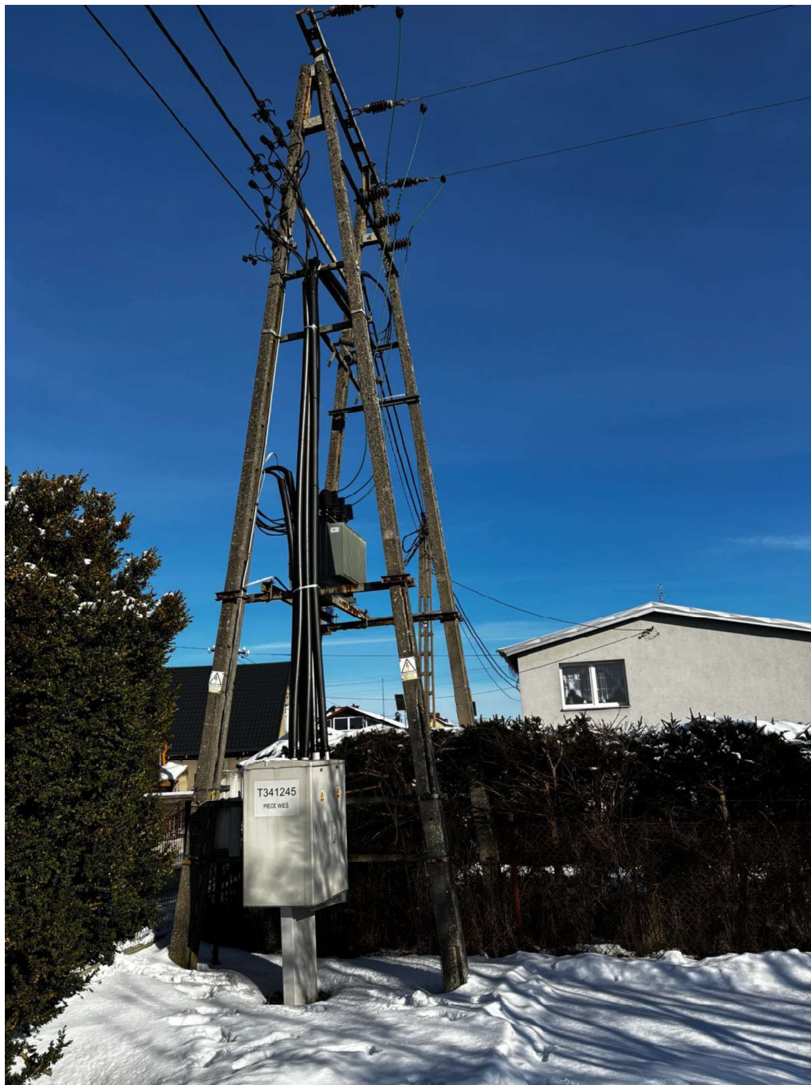
Istn. stacja transf. SN/nN T341245 "Piece Wieś".
